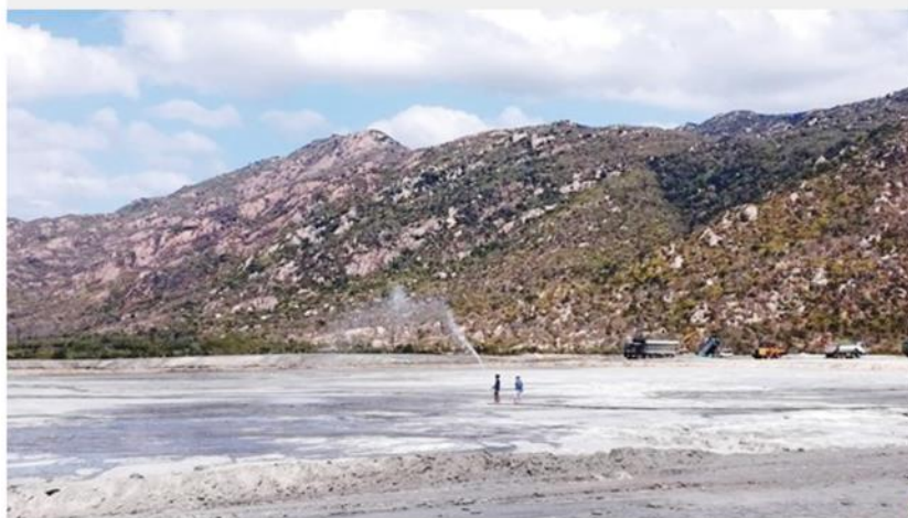
Bãi chứa tro xỉ than của Nhà máy Nhiệt điện Vĩnh Tân 2 đã cao hơn 10m
